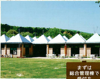
A 総合管理棟
